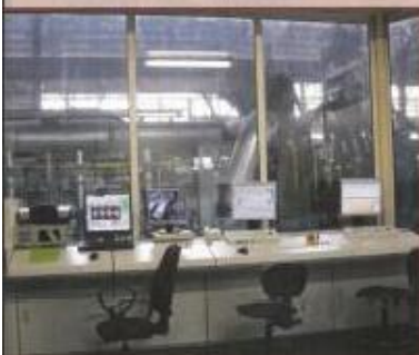
Ogólny widok sterowni linii obróbki cieplnej.
